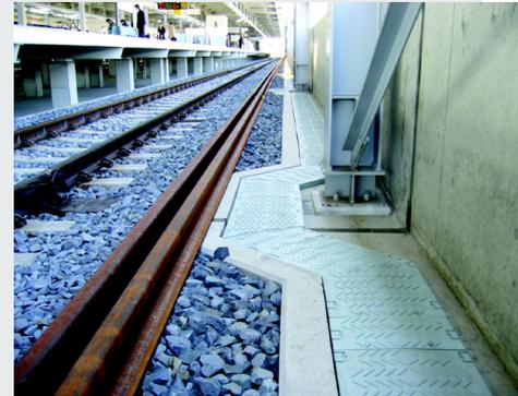
**i** Le caniveau en polymère est une alternative innovante et durable au caniveau en béton. Il a été conçu pour répondre à toutes les configurations et conditions d'installations possibles. Ses combinaisons modulaires assurent une rapidité d'installation.
